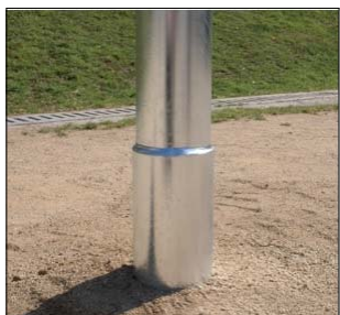
Detalle de la base del mástil reforzada.
